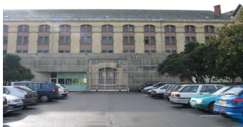
Photo n°3 : Bâtiment d'entrée de la prison 61
